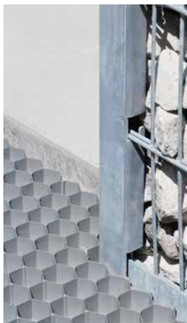
Grijze grindstabilisatiematten, nog op te vullen met grind.
