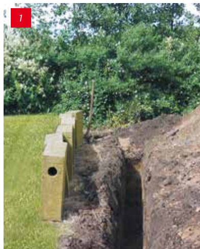
De inbouw is kinderspel. Je graaft simpelweg een sleuf met de spade of met een minigraafmachine.
