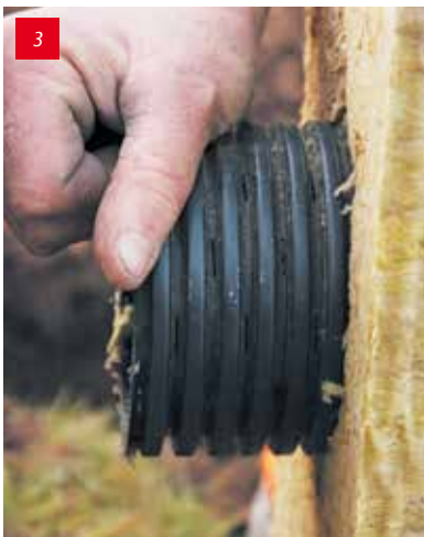
Handig insteekstelsysteem! Trek de doorvoerleiding vooraan uit elke Line 6 cm uit om alle aansluitingen makkelijk te leggen.
